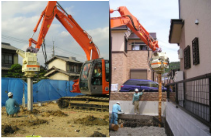
②オーガを取り外し、杭打ち装置で杭頭部を押さえ、油圧シヨベルの押し込み力との合成力で杭を打設する。
