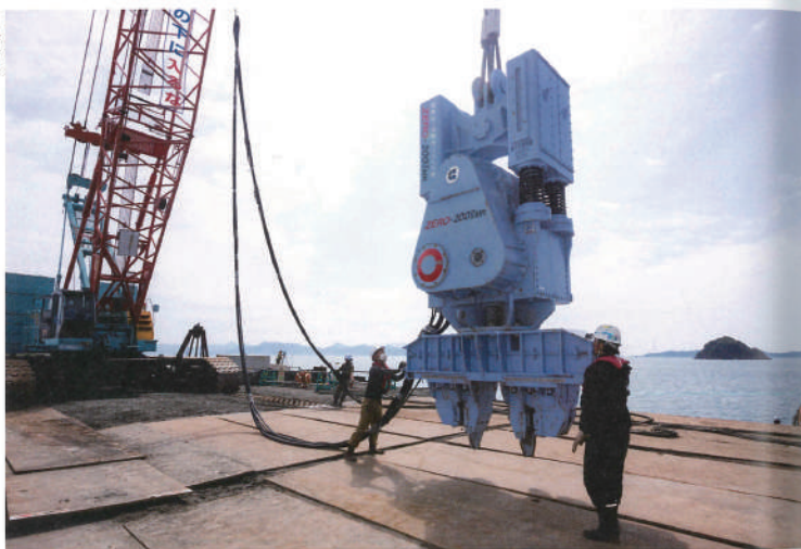
鋼管矢板の長さは42m。幸いこの日は風が穏やかだったが、海上は時化(しけ)や強風の影響を受けやすいため、作業は細心の注意を払いながら進められる
