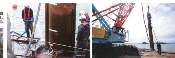
パイプロハンマーを稼働させ、海中への打ち込み作業が開始。地盤の硬さや状態にもよるが、一本あたり概ね一時間を要する。打ち込み時には震動で鉄板同士が擦れ合い、熱を持ってしまいうため、サポート役の職人が動作部分に海水をかけて冷却作業を行う
