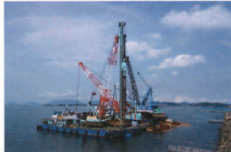
台船を使用した、海上での杭打ち風景。気象、海象などの変化を考慮した作業の進行管理には確かな経験や緻密な感覚と判断力が不可欠。まさに小山の技術が存分に発揮される現場と言える
