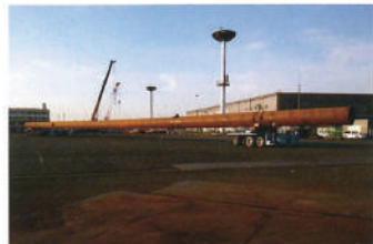
特殊トレーラーによる直径1800mm、長さ90m、重量90トンという超長尺鋼管杭の輸送風景。真っ直ぐ走らせるだけでも大変そうだ!
