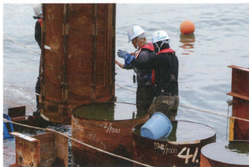
クレーンで杭打ちポイントまで運んだ後、矢板のオス型、メス型の溝を合わせ、最終的な位置決めを行う。その後、ウォータージェットを噴射させながら、自重で海中へと埋め込ませて行く
