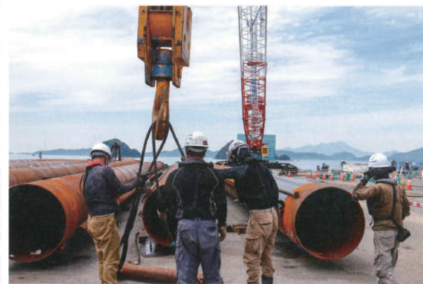
鋼管矢板にワイヤーをかけて、海側へと移動させるクレーンを持つ船長の松岡さん
