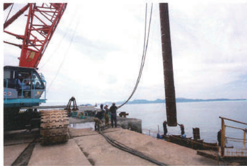
鋼管矢板の長さは42m。幸いこの日は風が穏やかだったが、海上は時化(しけ)や強風の影響を受けやすいため、作業は細心の注意を払いながら進められる
