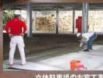
立体駐車場の左官工事
