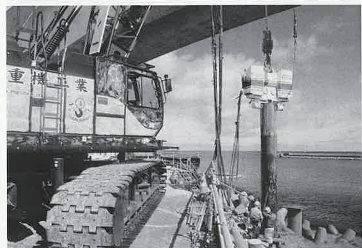
引抜き工事の様子
