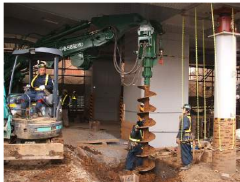
油圧オーガプレローリング
