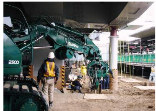
HHV-07Ziによる杭打設
