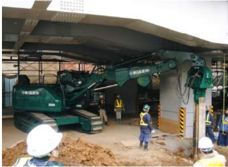
空頭制限下での打込作業
